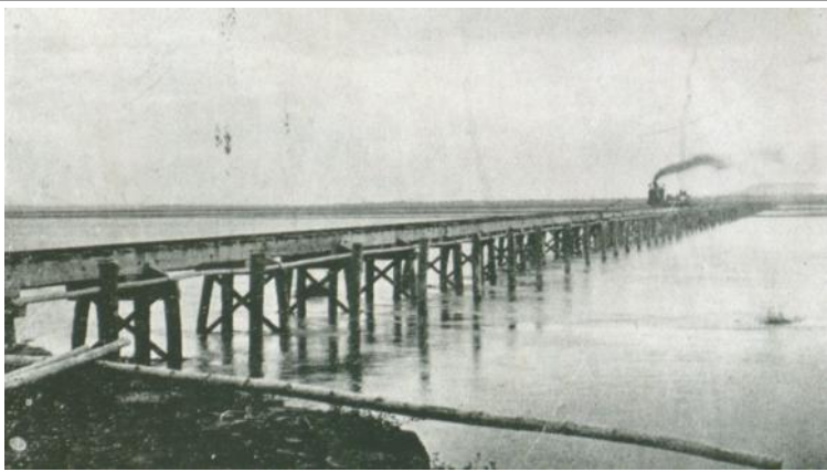
圖 15：下淡水溪（今高屏溪）輕便鐵橋【編號 0166_00_00_0078_a03】
