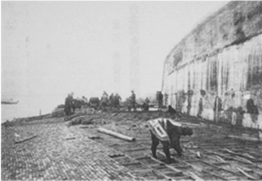
照片五 艋舺 RC 造防洪牆式堤防及串磚沈床施工舊照
