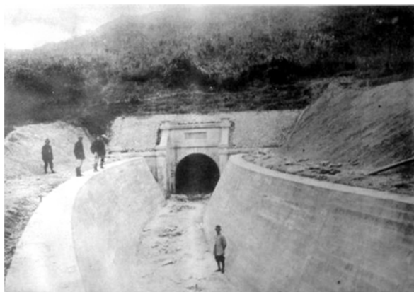
照片一 二層行溪埤圳圓仔潭隧道東口
