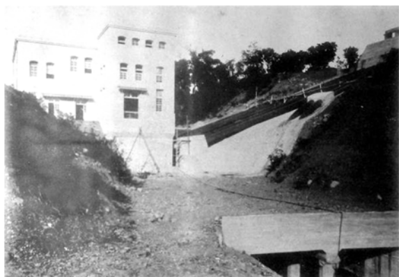
照片三 竣工不久之土壠灣發電所
